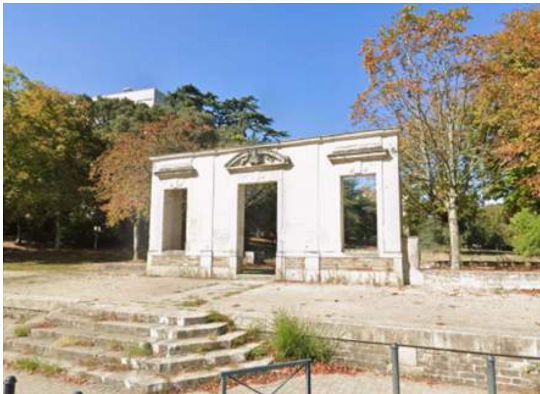
La façade du pavillon central du château ainsi que son soubassement ont été conservés.
